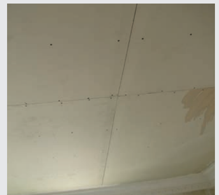
عدم رعایت حصارچینی در پنل‌ها
