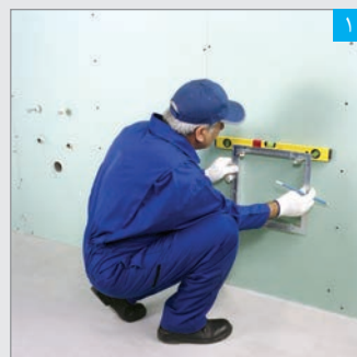
علامت گذاری محل نصب دریچه (با استفاده از قاب دریچه)
