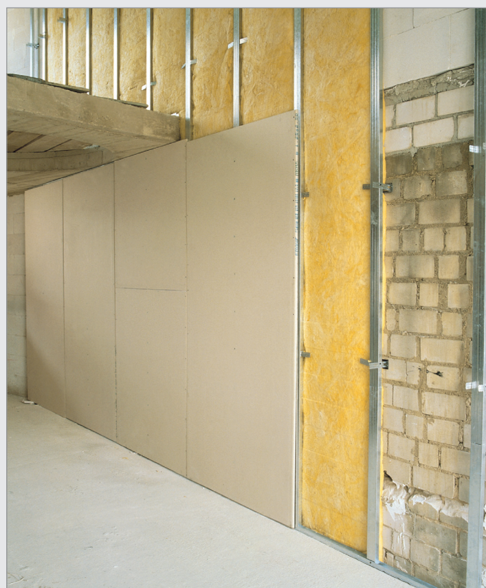
عایق کاری جدار ساختمان با دیوار پوششی
