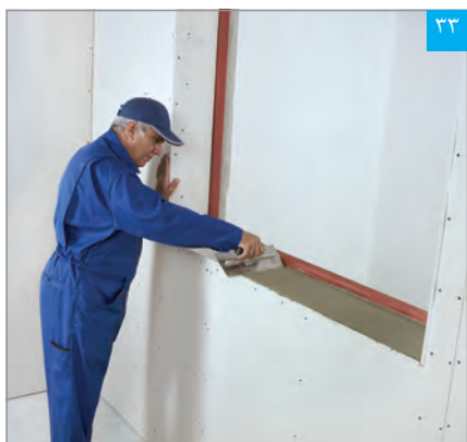
۳۳ اجرای چسب کاشی بر روی سطح پرایمر خورده
