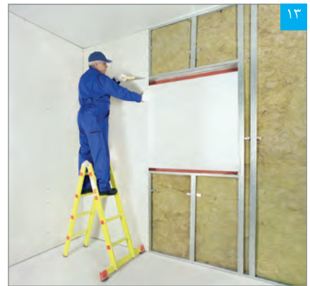
۱۳ برش پنل با استفاده از اره
