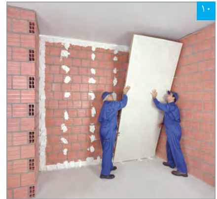
۱۰ پنل به سادگی توسط دو نفر قابل بلند کردن است
