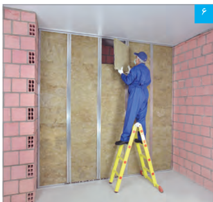
اجرای عایق پشم معدنی (توجه: در فاصله میان استاده‌ها)
