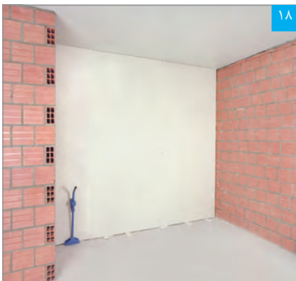
۱۸ پوشش کاری تکمیل شده
