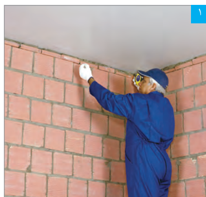
مشخص کردن محل نصب سازه هادی سقف با ریسمان رنگی
