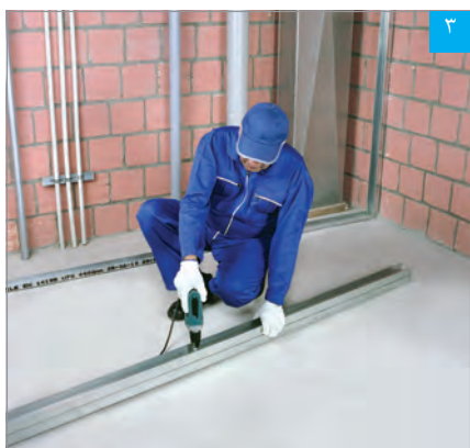
اجرای استادهای دوتایی
