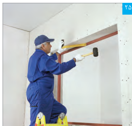
۲۵ تنظیم پنل نواری (گونیا کردن)
