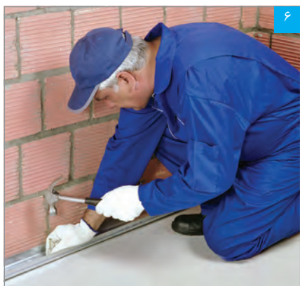
نصب رانر کف
