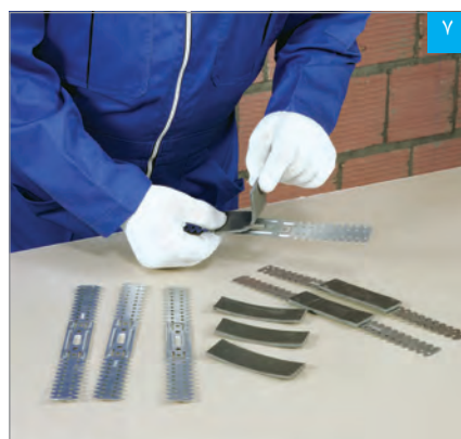
نصب قطعات فوم (عایق) بر پشت براکتها
