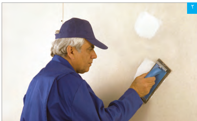
پرداخت سطح بتونه خشک
