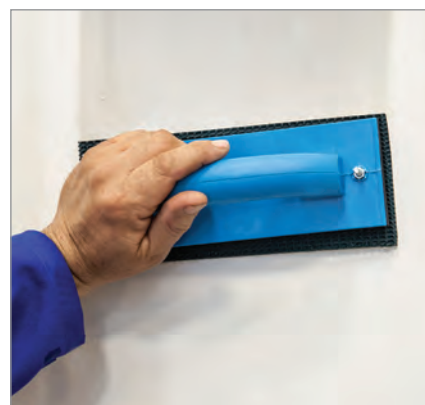
مرطوب کردن سطح دیوار با اسفنج نمدار
