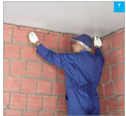
علامت‌گذاری مسیر لایه پوششی بر روی سقف (با استفاده از ریسمان رنگی)
