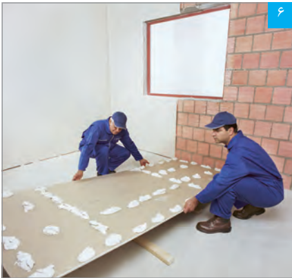
۶ به نحوه اجرای چسب گچی پنل (بوردفیکس) در محل بازشوی پنجره توجه شود
