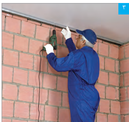
نصب سازه هادی سقف
