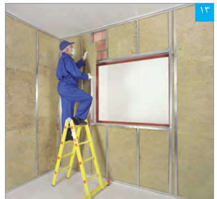
۱۳ اجرای عایق پشم معدنی
