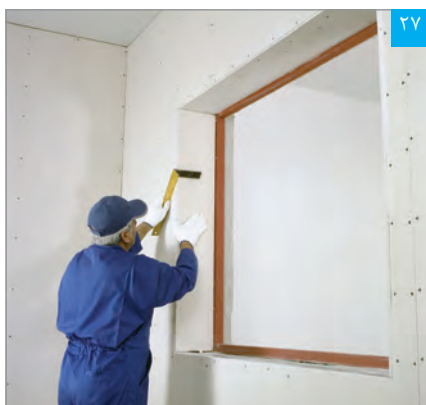
۲۷ تنظیم پنل نواری (گونیا کردن)
