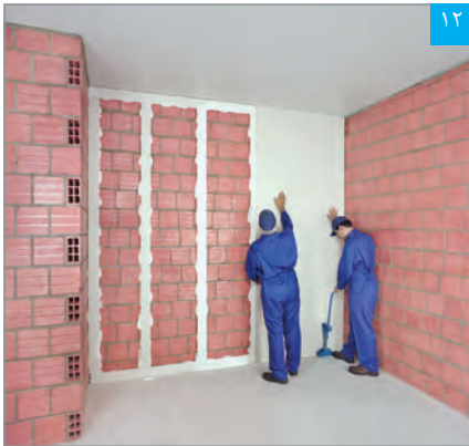
۱۲ نصب پنل با استفاده از جک نگهدارنده
