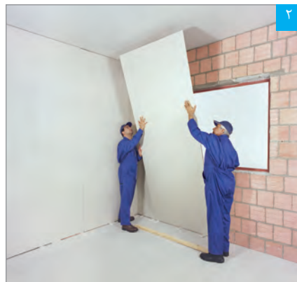
استقرار پنل بر روی دیوار زمینه
