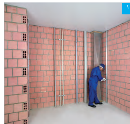
۱ نصب اولین رانر بر روی ساختار جانبی
