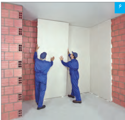
۶ استقرار پنل بر روی دیوار زمینه
