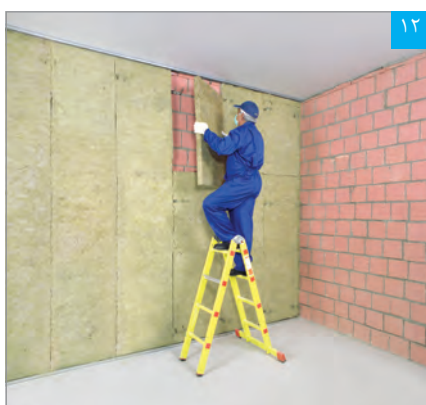
اجرای عایق پشم معدنی
