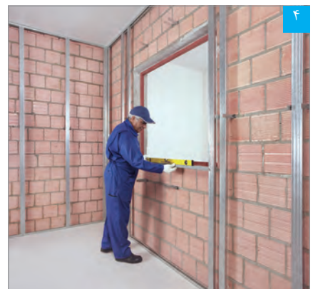
تنظیم سازه قاب‌بندی به وسیله تراز
