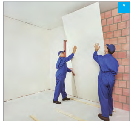
۷ استقرار پنل بر روی دیوار زمینه
