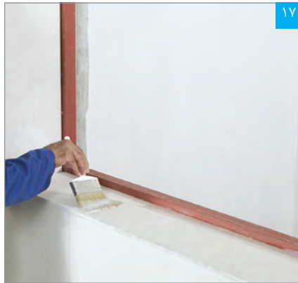
۱۷ اجرای پرایمر بر روی سطح پنل
