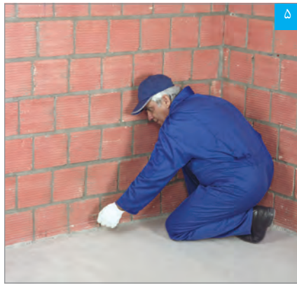
علامت‌گذاری مسیر لایه پوششی بر روی کف (با استفاده از ریسمان رنگی)
