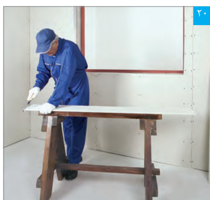
۲۰ برش پنل نواری (برای پوشش کاری ناحیه داخلی دور بازشوی پنجره)
