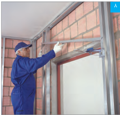
۸ استقرار رانر قاب‌بندی فوقانی (به جهت خم‌ها توجه شود)
