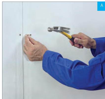
۸ اجرای عوامل اتصال کمکی برای جلوگیری از ناپایداری لایه پوششی در زمان وقوع حریق
