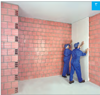
۳ استقرار پنل بر روی دیوار زمینه
