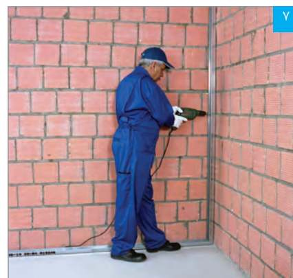
نصب اولین استاد بر روی ساختار جانبی
