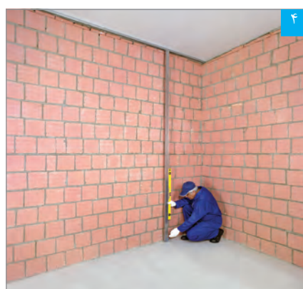
انتقال تصویر سازه هادی سقف به کف (با استفاده از استاد و تراز)
