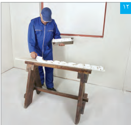
۱۲ اجرای چسب گچی پنل (بوردفیکس) بر پشت پنل نواری (برای پوشش کاری ناحیه داخلی دور بازشوی پنجره)
