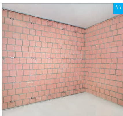
براکت‌های نصب شده
