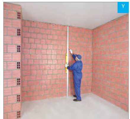
مشخص کردن محل اجرای چانه‌های چسب گچی پنل (بوردفیکس) بر روی دیوار زمینه
