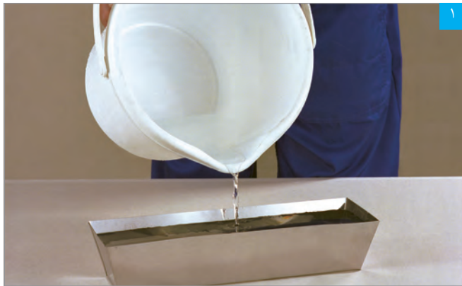
ریختن آب در ظرف تهیه بتونه
