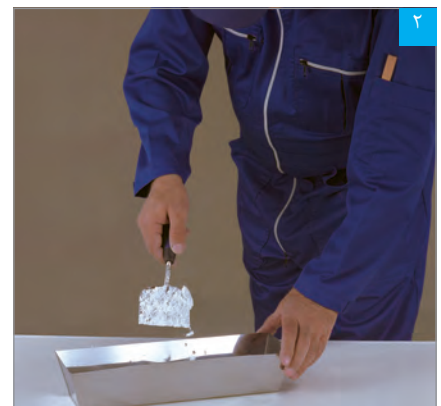
ریختن پودر بتونه در آب
