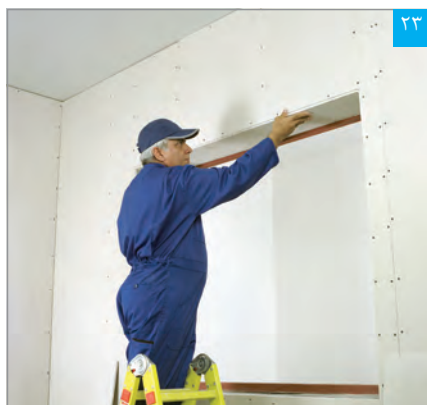
۲۳ تنظیم لبه های پنل در محل کنج
