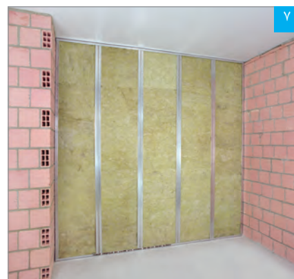
لایه عایق تکمیل شده
