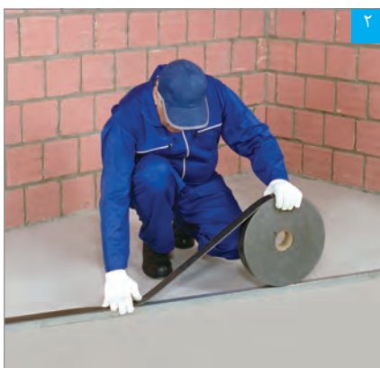
اجرای نوار عایق (با دو ردیف خمیر درزبند) بر پشت جان رانر کف و سقف
