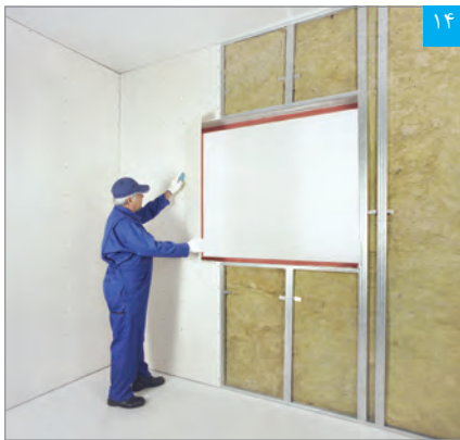
۱۴ برش پنل با استفاده از تیغ برش
