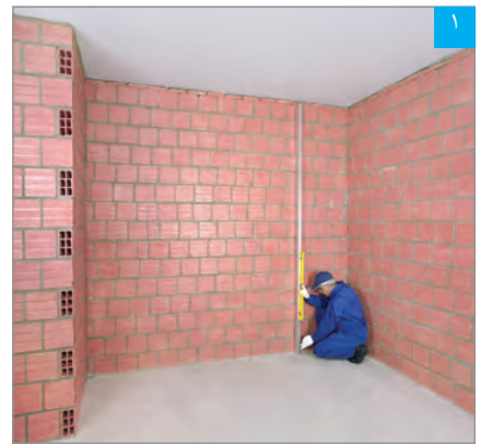
شمشه‌گذاری بر روی دیوار زمینه، جهت تعیین ناترازی آن و علامت‌گذاری روی کف
