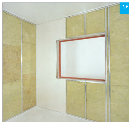
۱۶ در محل بازشوی پنجره، برش پنل به صورت «C» شکل صورت می‌گیرد
