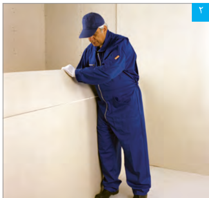
شکستن پنل در محل برش
