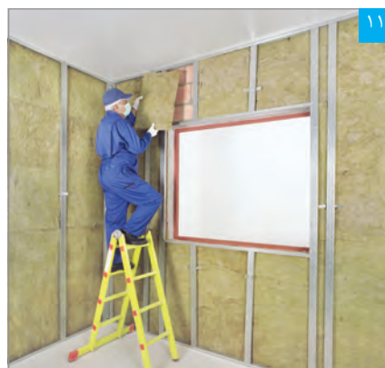
اجرای عایق پشم‌معدنی
