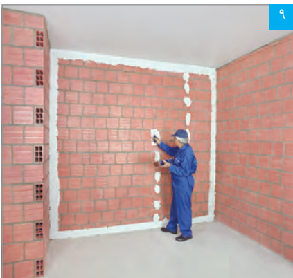
اجرای چانه‌های چسب گچی پنل (بوردفیکس) بر روی دیوار زمینه (در فواصل مرکز به مرکز حداکثر ۳۵ س.م)
