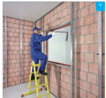
استقرار سازه قاب‌بندی فوقانی (به جهت خم‌ها توجه شود)
