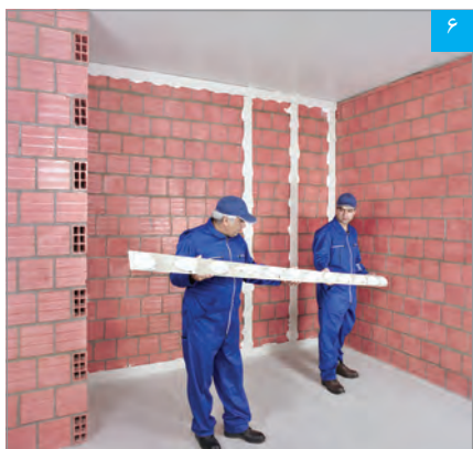
چانه‌های چسب گچی پنل (بوردفیکس) در فواصل حداکثر ۲۵ سانتی‌متر (مرکز به مرکز) بر پشت کرم ها قرار می‌گیرند
