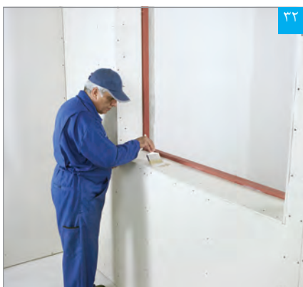
اجرای پرایمر بر روی سطح پنل
