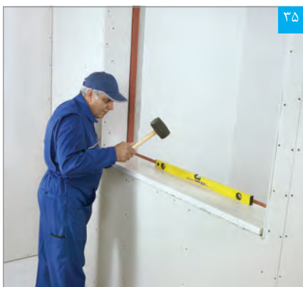
نصب و تنظیم سنگ کف پنجره
