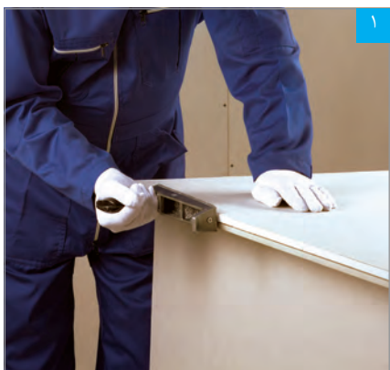
پرداخت لبه برش‌خورده با رنده
