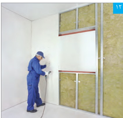
نصب پنل بر روی زیرسازی
