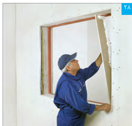
۲۸ استقرار پنل نواری در ناحیه داخلی دور بازشوی پنجره (به اجرای یکپارچه چسب گچی پنل (بوردفیکس) توجه شود)
