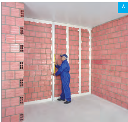
بررسی تراز و تنظیم بودن کرم نصب شده با استفاده از شمشه و تراز
