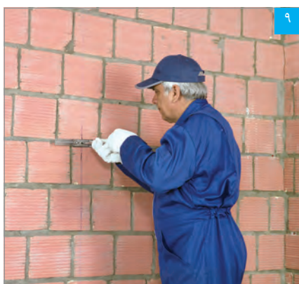
نصب براکت بر روی دیوار زمینه
