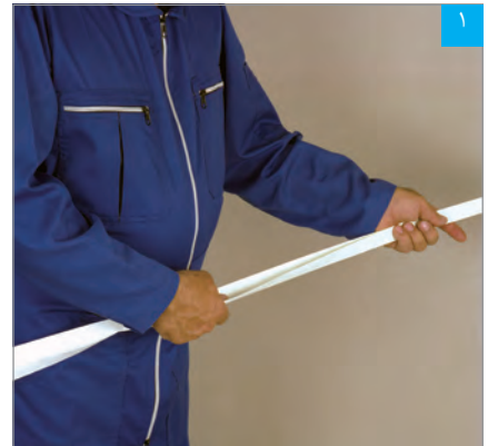
خم کردن نوار درزگیر با دست
