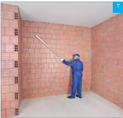
شمشه‌گذاری به صورت مایل بر روی دیوار زمینه، جهت بررسی ناهمواری در طول دیوار
