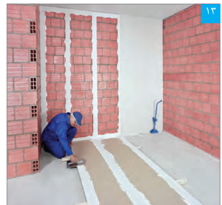
۱۳ لایه نواری بتونه درزگیر را می‌توان بر پشت پنل‌ها اجرا نمود
