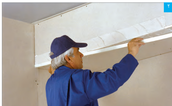
قرار دادن نوار درزگیر بر روی بتونه
