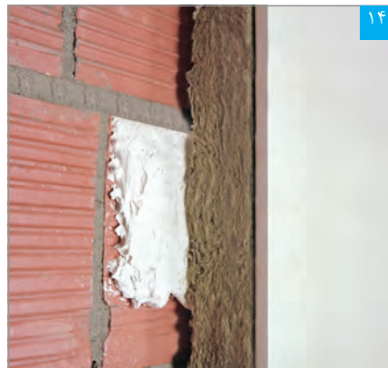
۱۴ ضخامت چانه چسب گچی پنل (بوردفیکس) پس از نصب و فشردن پنل باید حداقل ۵ میلی‌متر باشد
