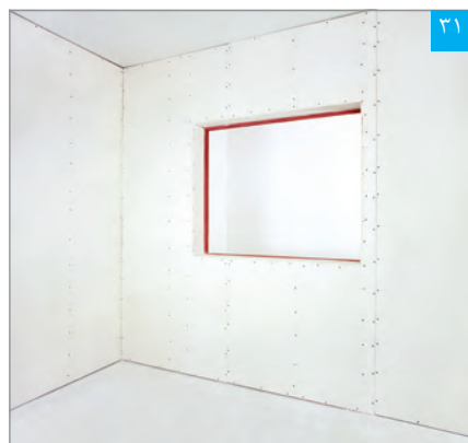
۳۱ پوشش کاری تکمیل شده در ناحیه بیرونی و درونی بازشوی پنجره
