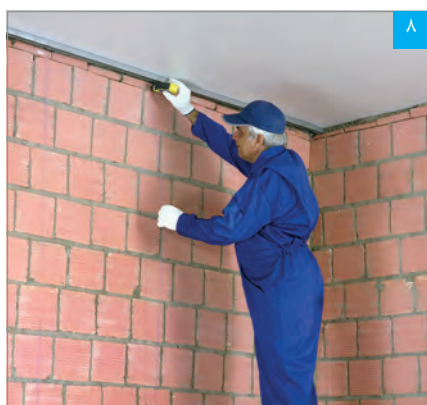
مشخص کردن محل نصب براکتها بر روی دیوار زمینه
