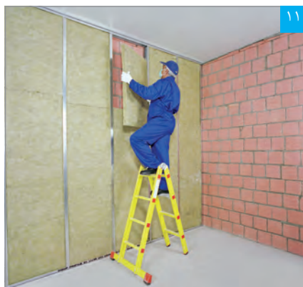
اجرای عایق پشم‌معدنی (توجه: در فاصله میان استادها)
