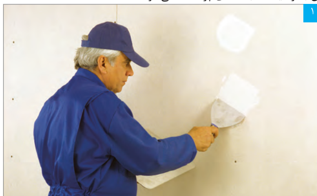
اجرای بتونه در محل پیچ‌ها
