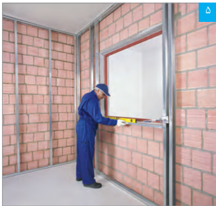
۵ تنظیم رانر قاب‌بندی تحتانی به وسیله تراز
