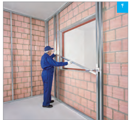
۴ استقرار رانر قاب‌بندی تحتانی (به جهت خم‌ها توجه شود)
