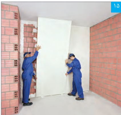
۱۵ پنل‌ها بر روی محور مرکزی ردیف‌های چسب گچی پنل (بوردفیکس) مستقر می‌شوند
