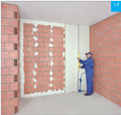
۱۲ بررسی تراز و تنظیم بودن پنل نصب شده با استفاده از شمشه و تراز
