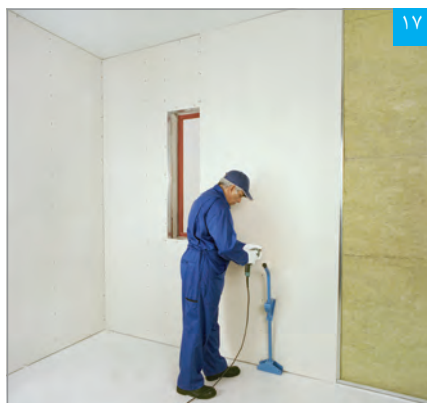
۱۷ نصب پنل بر روی زیرسازی
