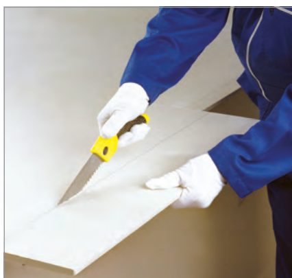
برش پنل با اره دستی
