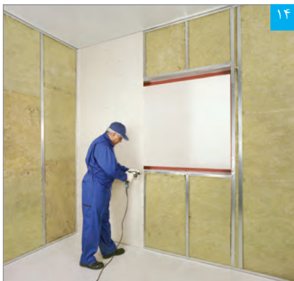
۱۴ نصب پنل بر روی زیرسازی
