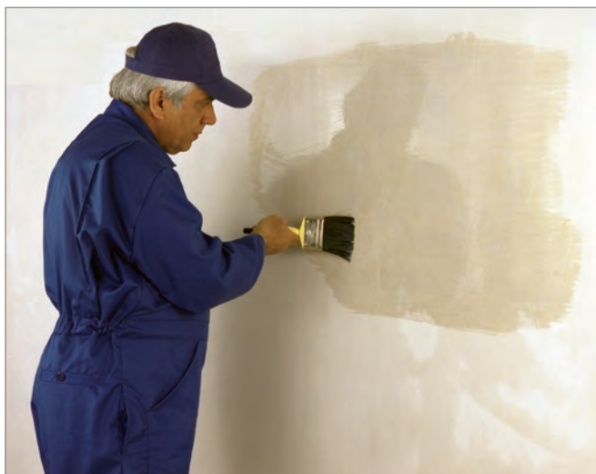
اجرای لایه پرایمر بر روی ماستیک قبل از رنگ‌آمیزی با رنگ روغنی
