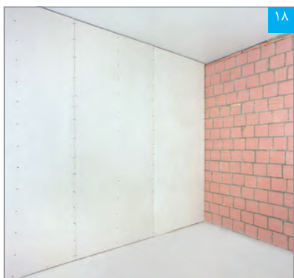
دیوار پوششی تکمیل شده
