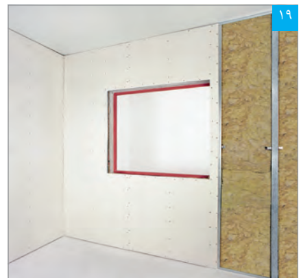
۱۹ پوشش کاری تکمیل شده در ناحیه بیرونی بازشوی پنجره
