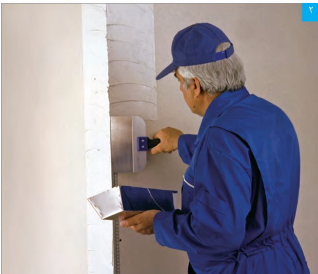
اجرای بتونه روی سازه محافظ گوشه
