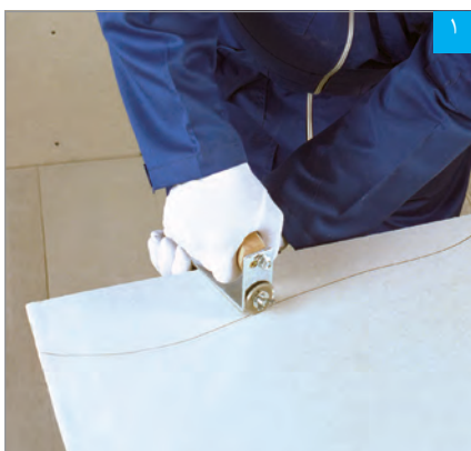
اجرای برش موج‌دار با دستگاه برش قرقره‌ای
