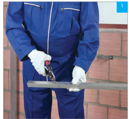
برش انتهای سازه‌های افقی قاب‌بندی بازشوی پنجره (به اندازه ۲۰ سانتی‌متر و به صورت فارسی بر)
