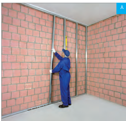
اجرای استاده‌ها (به صورت شاقولی)
