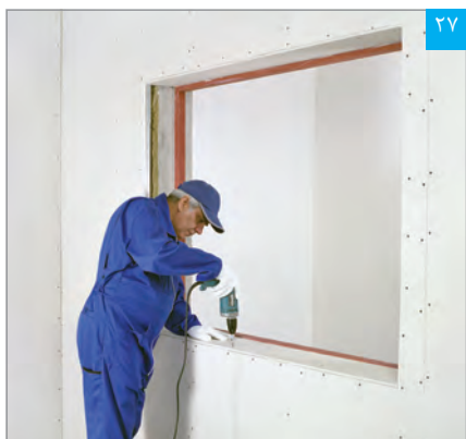
۲۷ اتصال پنل نواری به سازه قاب‌بندی تحتانی
