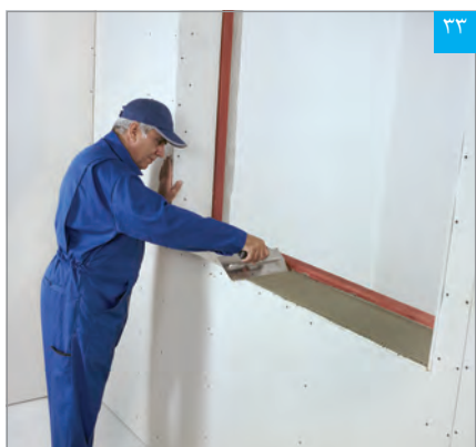
اجرای چسب کاشی بر روی سطح پرایمر خورده
