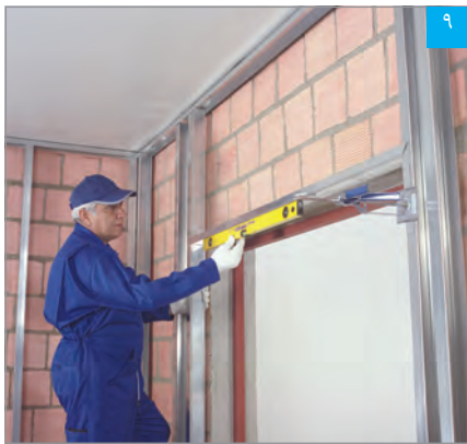
۹ تنظیم رانر قاب‌بندی فوقانی به وسیله تراز
