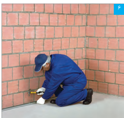
نصب سازه هادی کف
