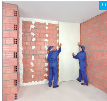
۱۱ استقرار پنل بر روی دیوار زمینه
