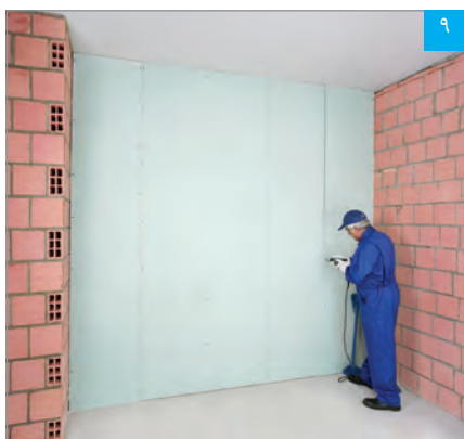
نصب لایه دوم پنل‌ها و تکمیل ساختار
