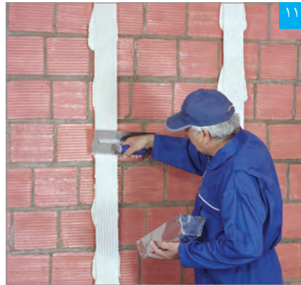
۱۱ اجرای لایه بتونه درزگیر بر روی کرم‌ها با استفاده از ماله دندان‌دار
