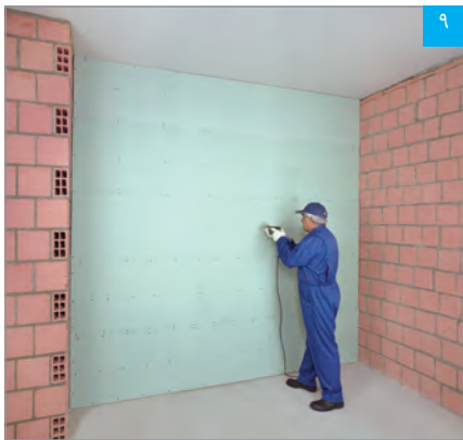
نصب لایه دوم پنل ها و تکمیل ساختار
